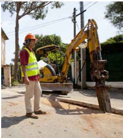
BRH monté sur mini-pelle
